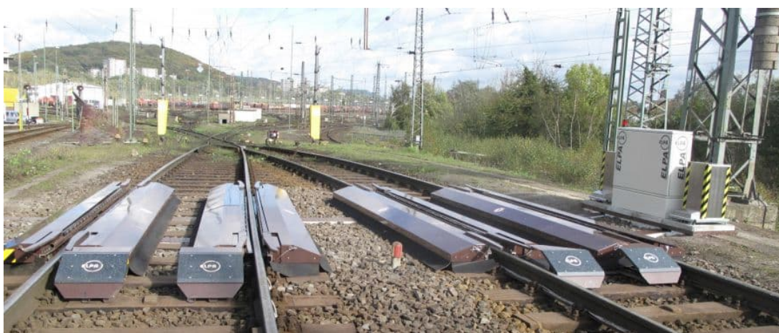
Slika 25. Prikaz ugrađenog sustava za primjenu maziva 27
