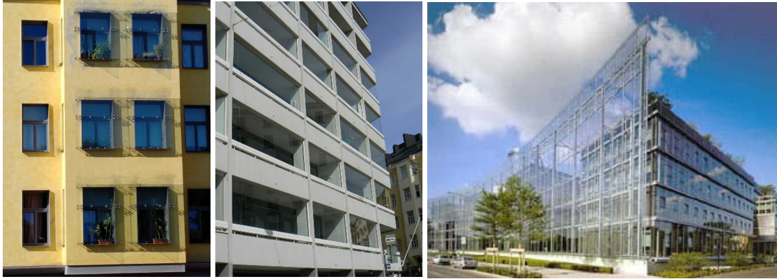
Slika 19. Prikaz ostakljenih zidova za zaštitu od buke
