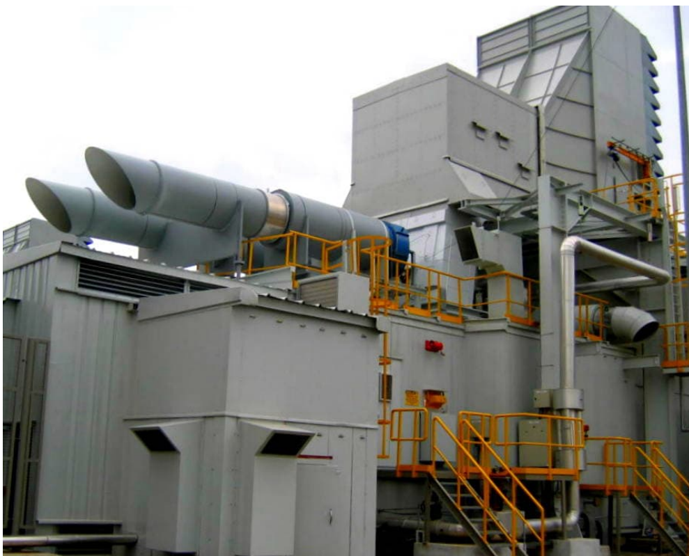
Slika 38. Karakterističan prikaz akustičkog oklapanja izvora buke ( poveznica )
