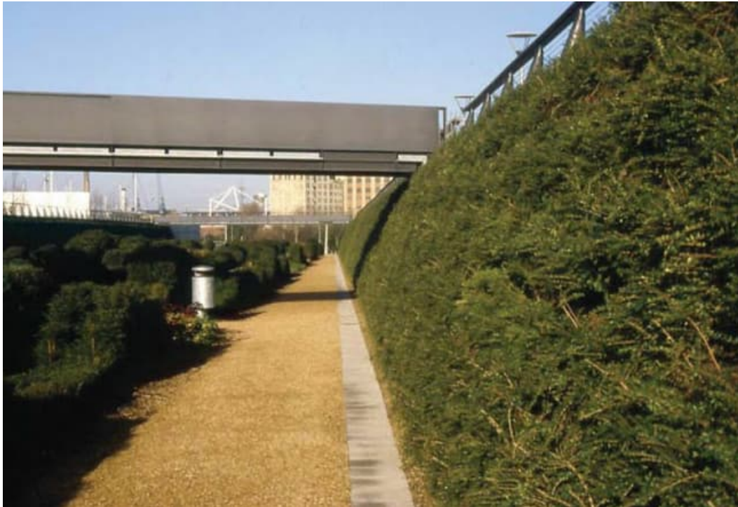
Slika 22. Prikaz izvedbe „ozelenjenog“ zida za zaštitu od buke
